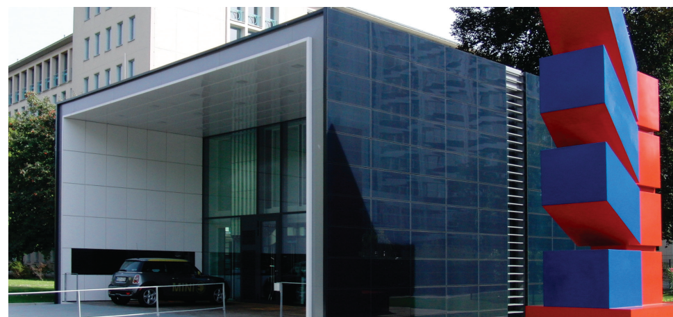
Effizienzhaus Plus dům s elektromobilitou v Berlíně
